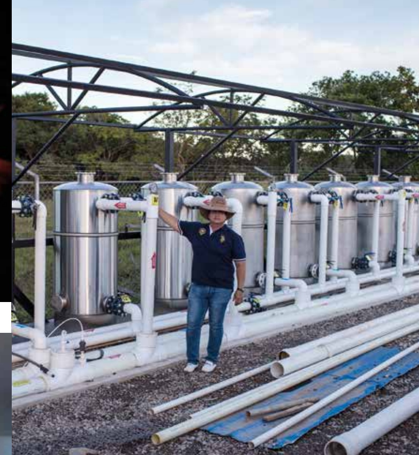
▲ Jhon Jairo construyó una planta potabilizadora de agua para las cerca de tres mil viviendas que se levantarán en La Bendición. En Yopal, en cambio, no hay agua potable.
