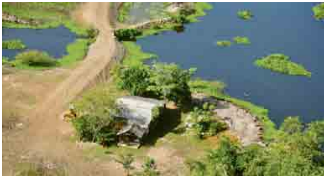
Además de los diques, sobre los caños también han construido puentes.
