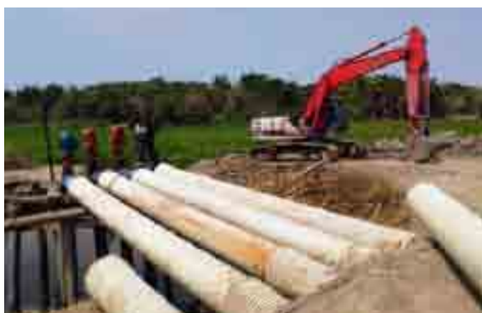
La Policía informó que incautó siete hidrobombas y una retroexcavadora en la finca Mendegua, en Remolino.
