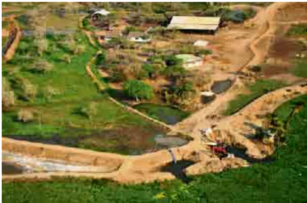
Zona afectada del caño Condazo. La Policía no incautó una segunda retroexcavadora que estaba en la finca Mendegua donde construyen los terraplenes.
